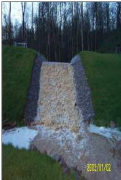
Exemple de déversoir de sécurité actif (vue de l'aval)
